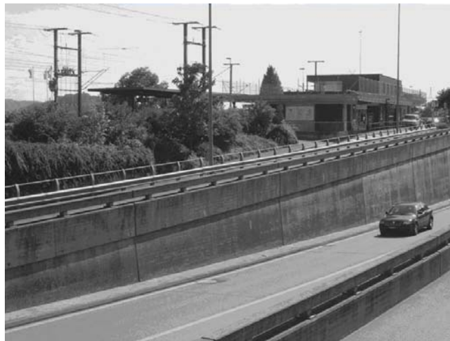
Abb. 8: Bahnhof und Autostrasse in Twann, eigene Fotografie, 2005
