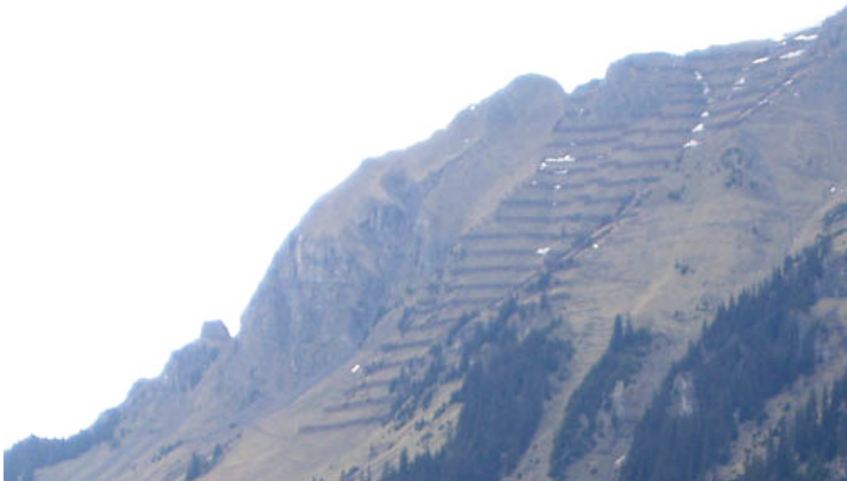
Abbildung 14: Lawinerverbauungen oberhalb von Wengen, Foto: Notter 2005.
