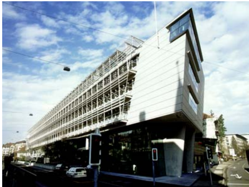
Abbildung 4: Verwaltungsgebäude Titanic II Quelle: R. Rast Architekturbüro AG
