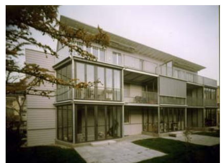
Renovation eines Mehrfamilienhauses in Therwil (BL)
